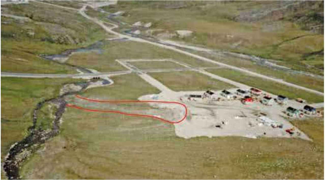
Figure 7. Cette rupture par décrochement de la couche active à Salluit est survenue en 1998 et a provoqué l'abandon du projet de développement dans ce secteur ainsi que le déplacement de 20 maisons déjà bâties.
