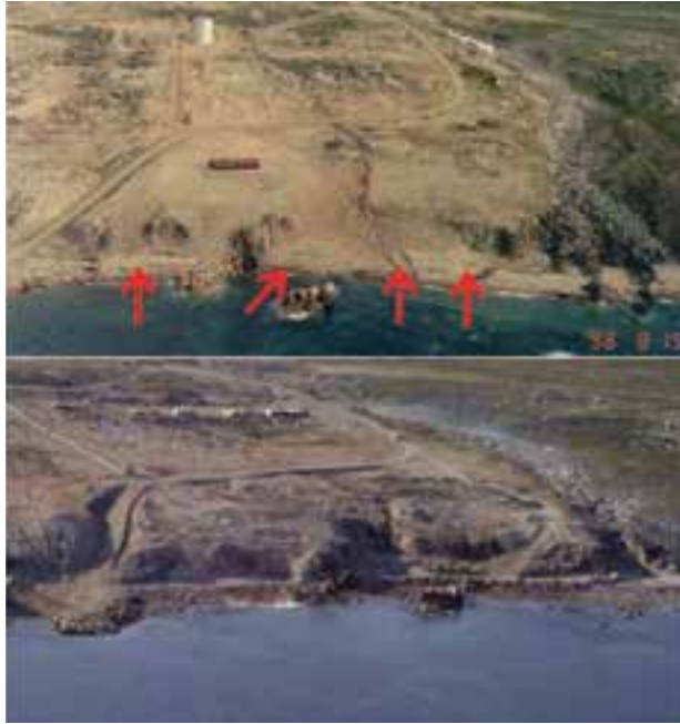
Figure 3. Secteur de la plage du mouillage de Saglek avant (photo supérieure, 1996) et après (photo inférieure, 1999) l'excavation et le retrait des sédiments contaminés. Le volume de sédiments retirés était de 16 240 m 3 (les flèches indiquent les endroits où les sédiments ont été retirés), assez pour couvrir un terrain de football à une profondeur d'environ 4 m). Le ruissellement et l'érosion des sédiments transportaient les BPC au large dans la baie.
