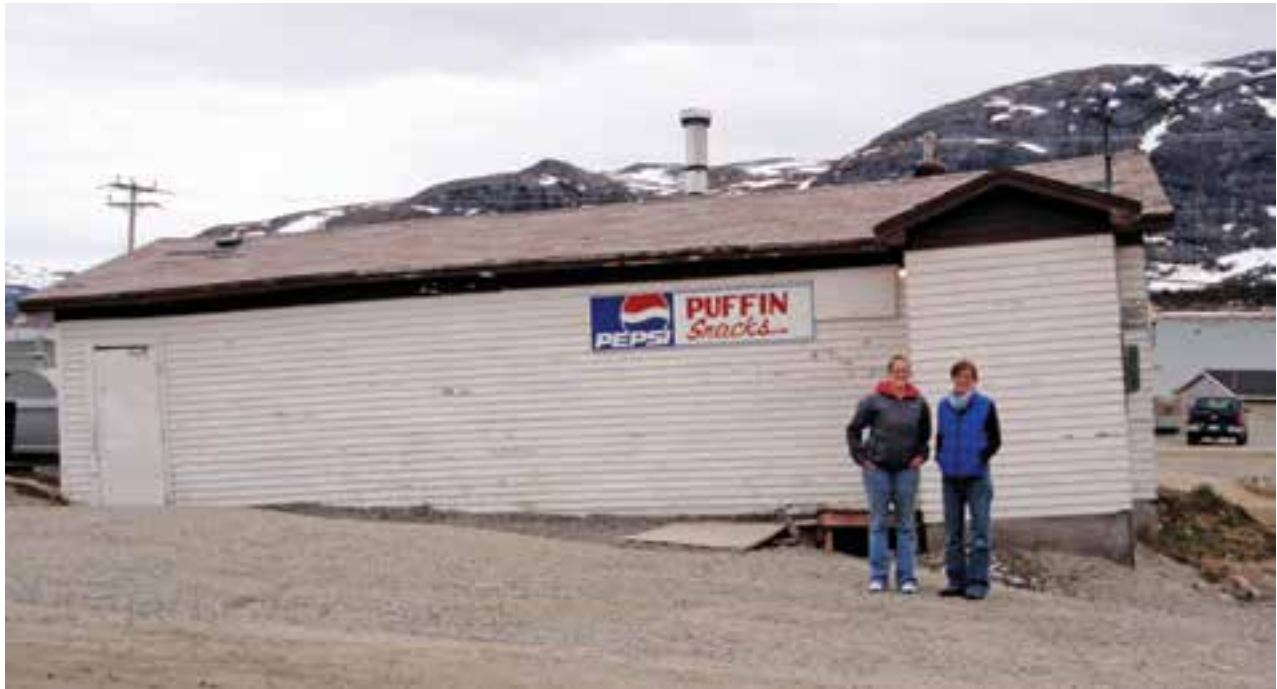
Figure 9. Subsidence du sol liée au dégel du pergélisol qui cause des dommages structurels et des problèmes de maintenance des infrastructures à Nain, au Nunatsiavut.
